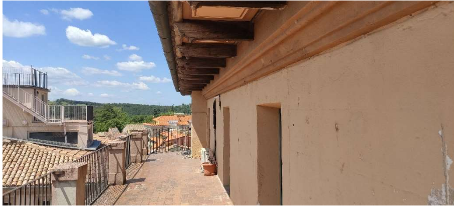
Imatge Terrat accés a coberta sud
