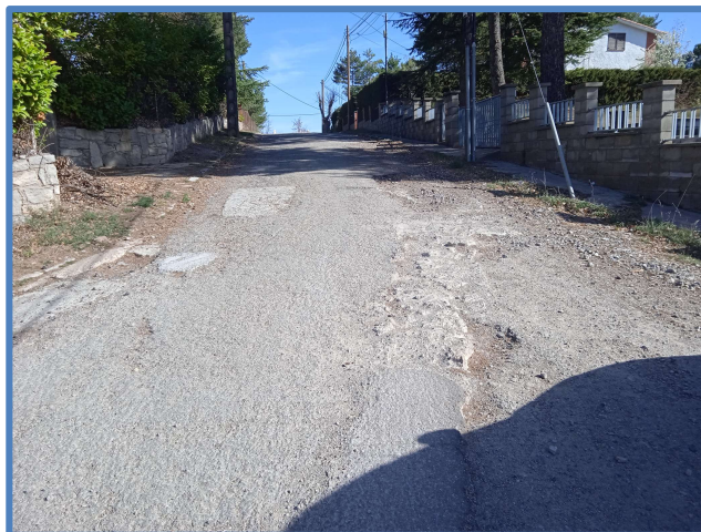
Estat actual carrer Montseny des de la intersecció amb carrer de la Mare de Déu de la Mercè
