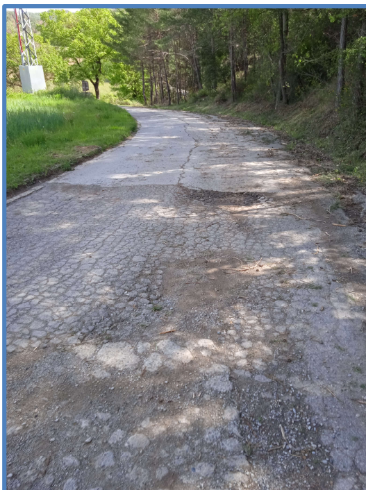
Estat actual tram carrer Vilalta a actuar i connexió a actuació anterior.
