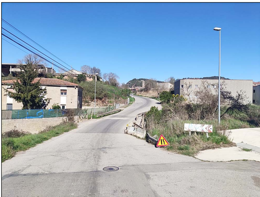
Foto 02 – Vista general de l'accés al pont pel costat est.
