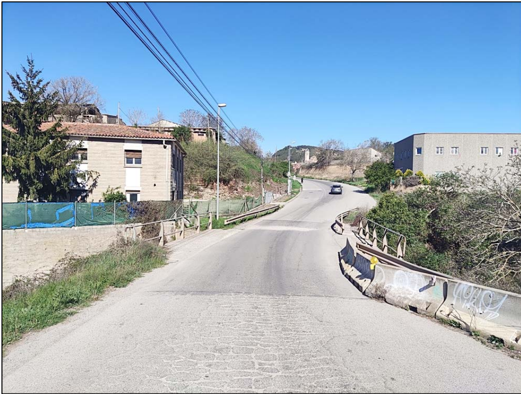
Foto 03 – Vista general de l'accés al pont pel costat est.
