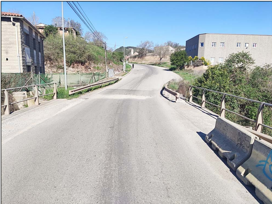
Foto 04 – Vista general de l'accés al pont pel costat est.
