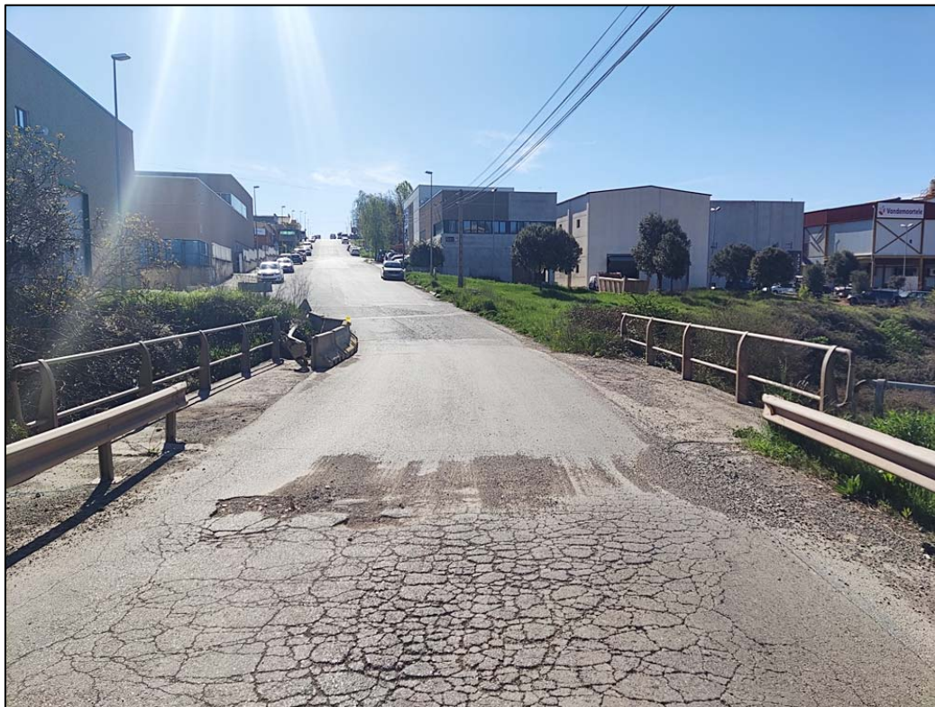
Foto 05 – Vista general de l'accés al pont pel costat oest.
