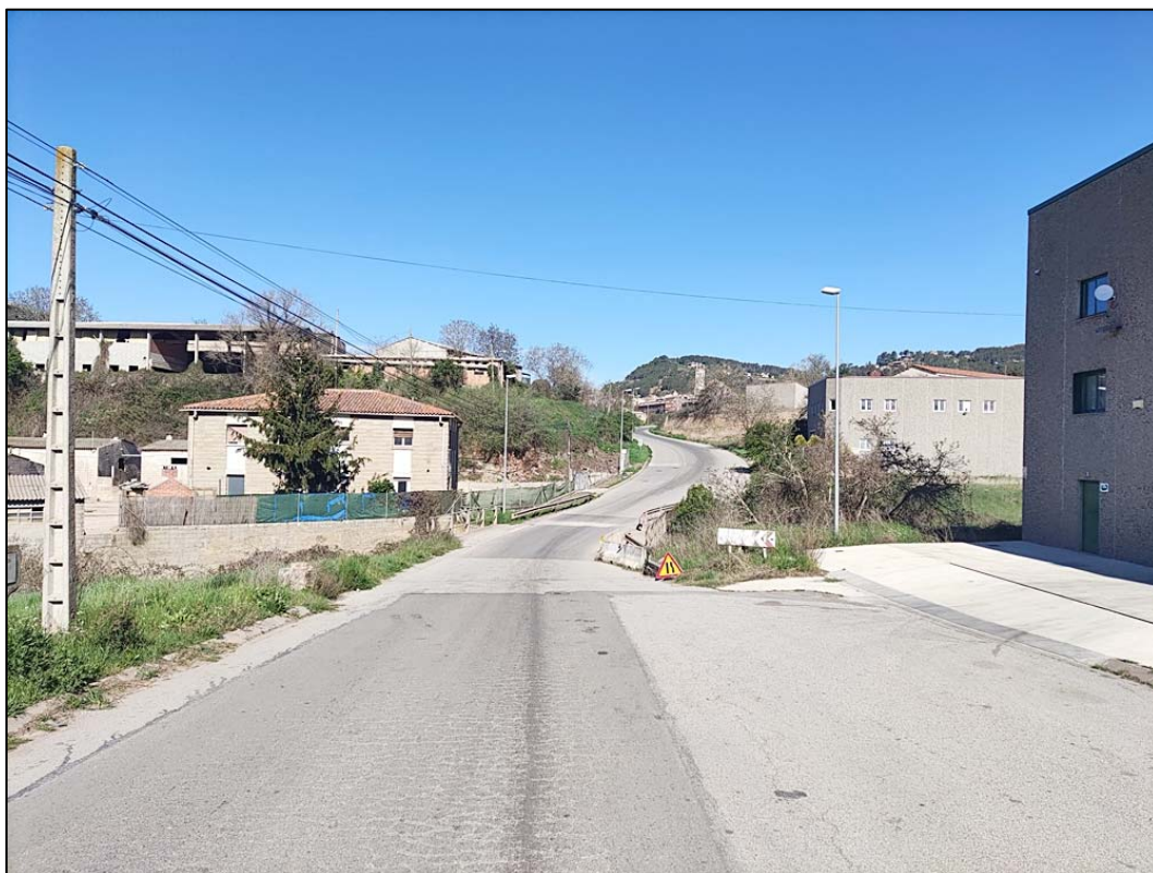
Foto 01 – Vista general de l'accés al pont pel costat est.
