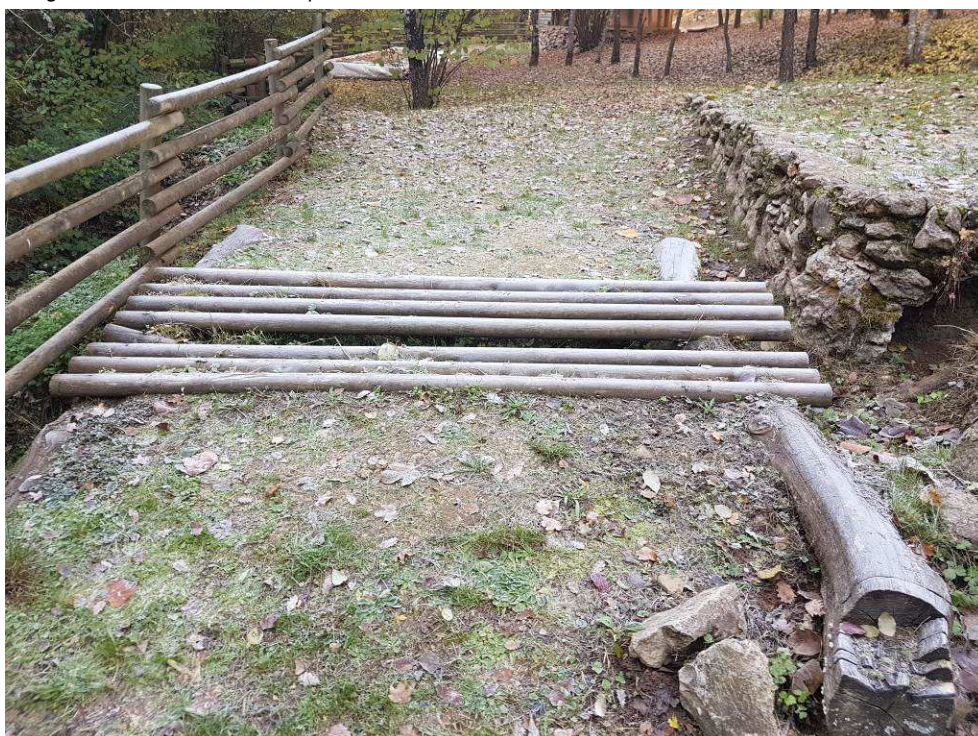
Imatge 12: pas sobre desguàs a reparar
