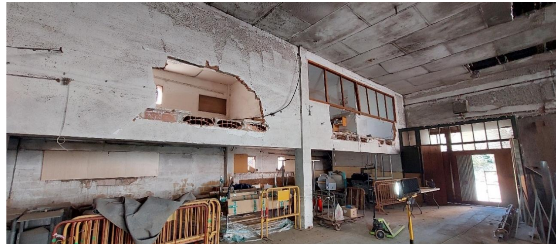
Mezzanine de Nau sud
