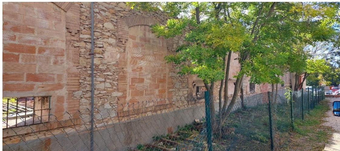
Façana oest – Nau original
