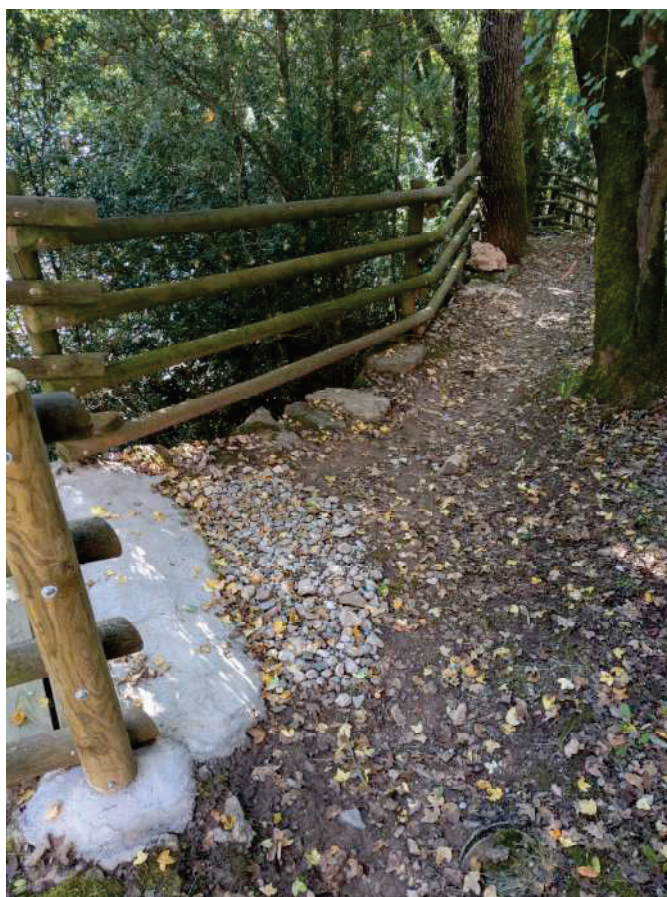
Imatge 17: Estat actual del tram amb erosió de la Cova Morta.
