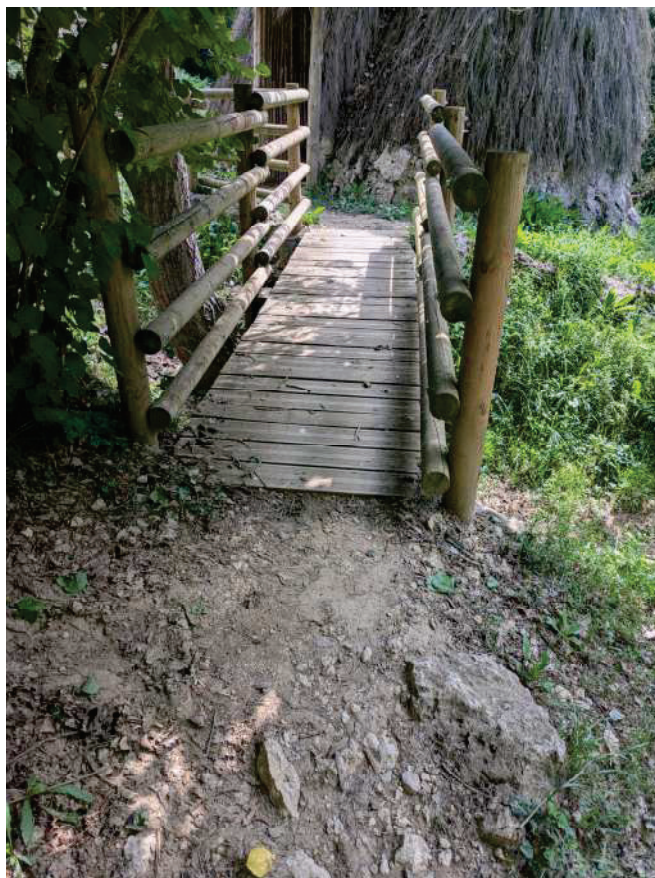
Imatge 14: Estat actual dels ponts de fusta
