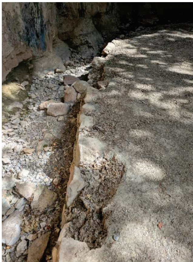
Imatge 16: Estat actual del mur de drenatge de la surgència
