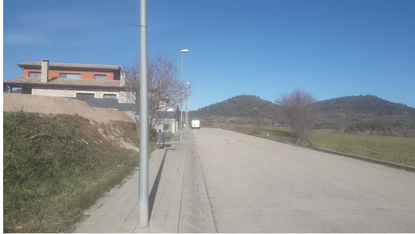
Vista del carrer Mercè Rodoreda consolidat, encintats, vorera i calçada
