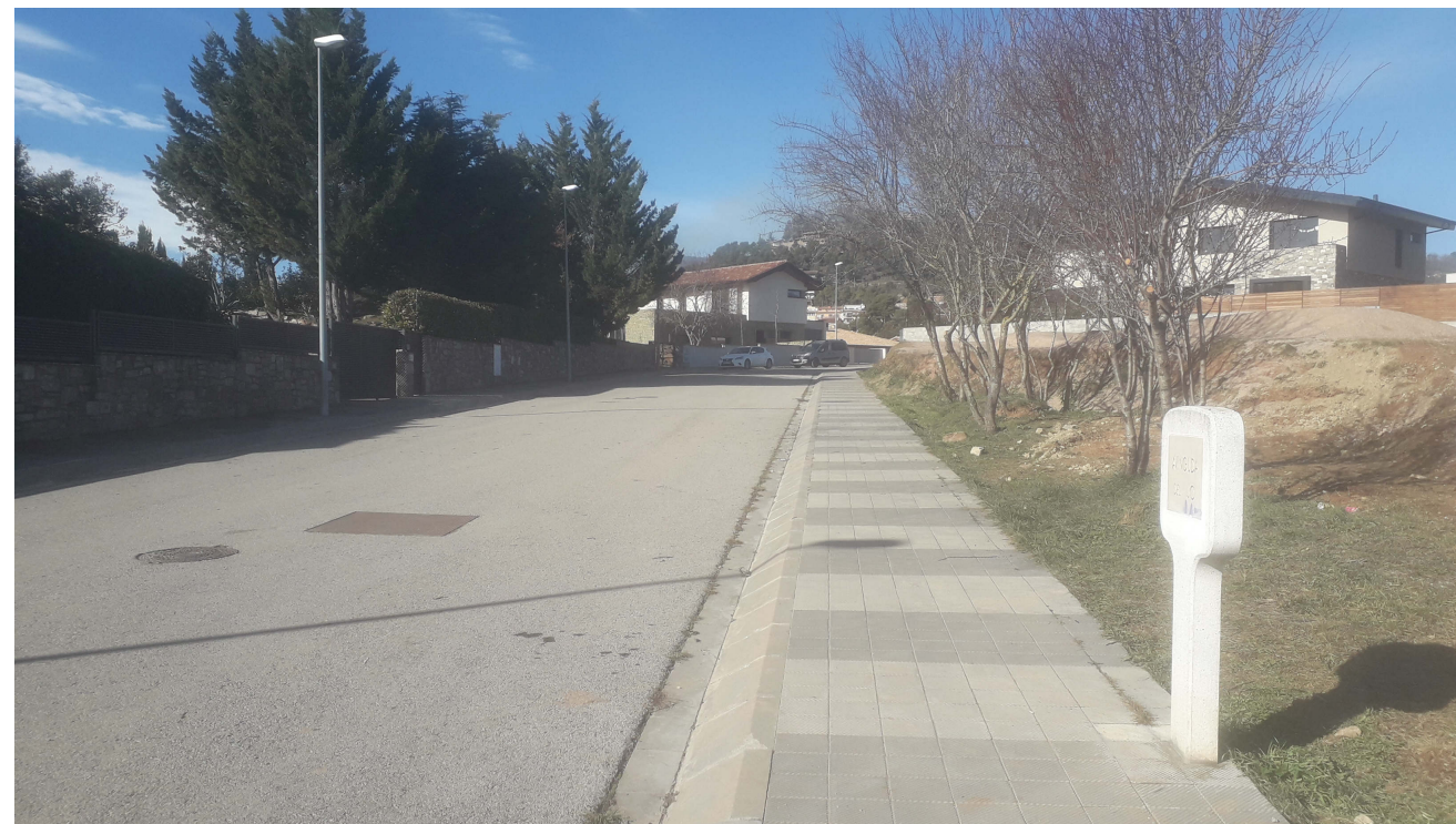
Vista de l'Avinguda del Jo consolidat, encintats, vorera i calçada
