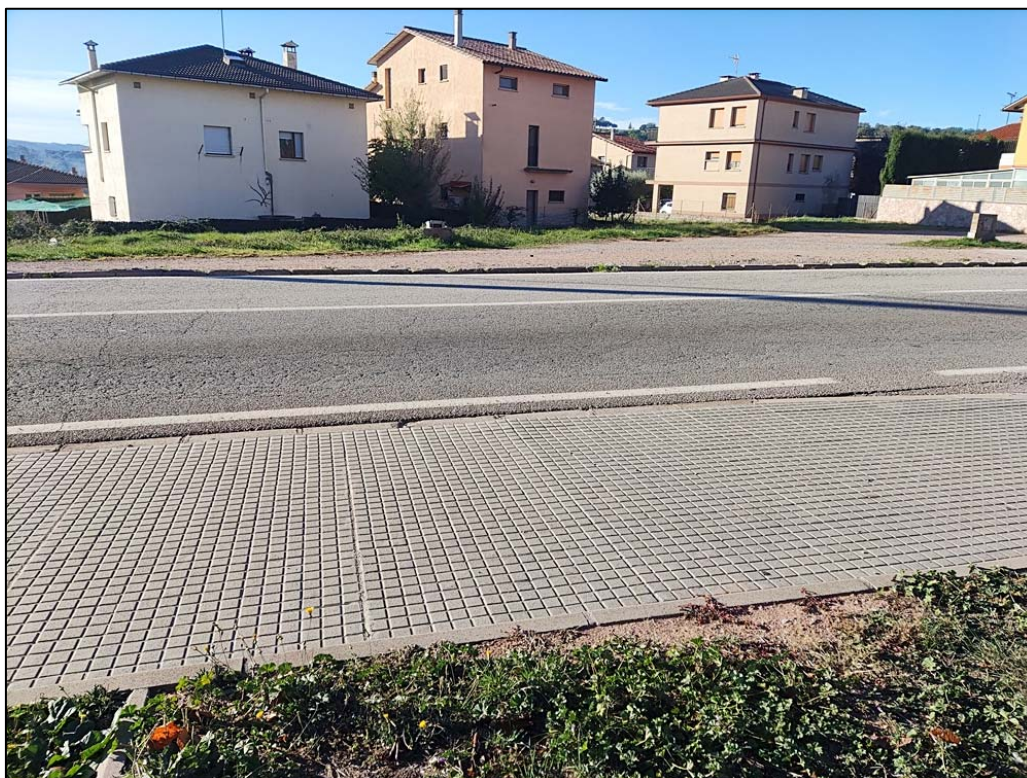
Foto 07 – Zona on es preveu la implantació del nou pas de vianants, creuament de la carretera de Manresa (N-141c).
