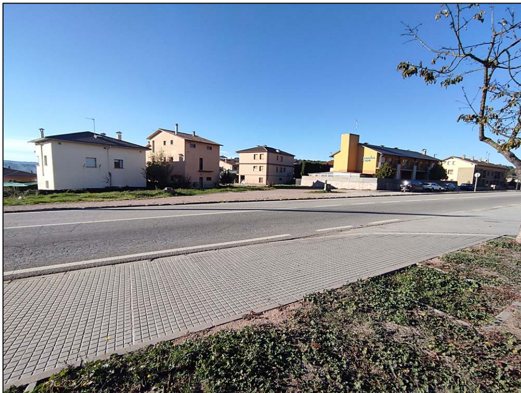
Foto 06 – Zona on es preveu la implantació del nou pas de vianants, creuament de la carretera de Manresa (N-141c).
