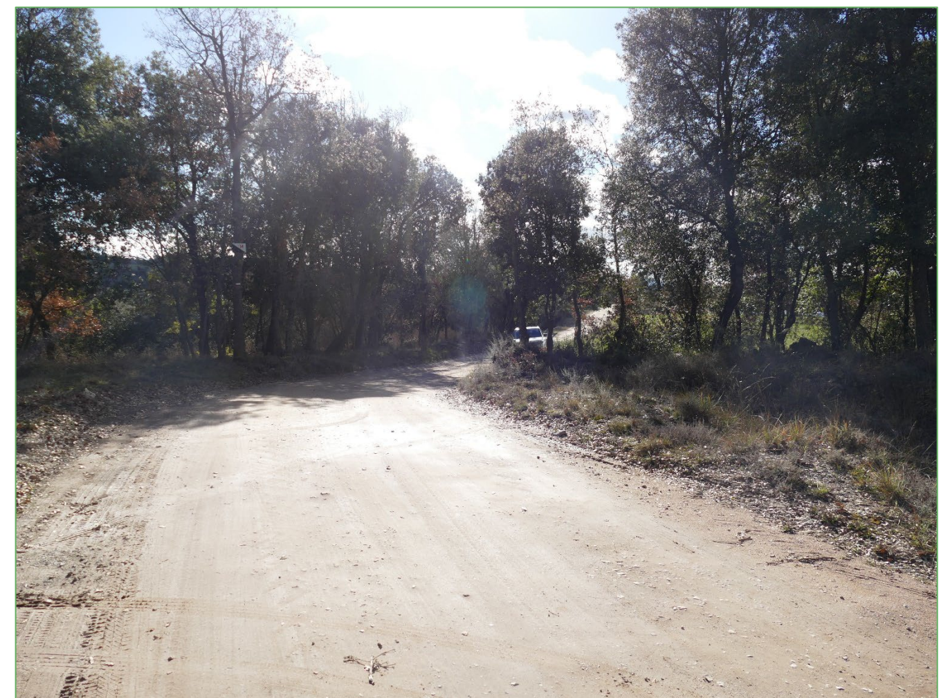
PQ 1+002 final del tram
