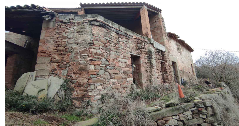
Fotografia de conjunta: nau i església. Façana sud-est.
