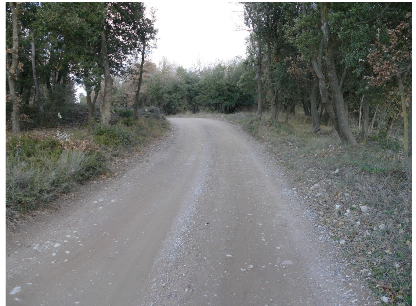
PQ 0+810 inici corba amb pendent existent en traçat actual
