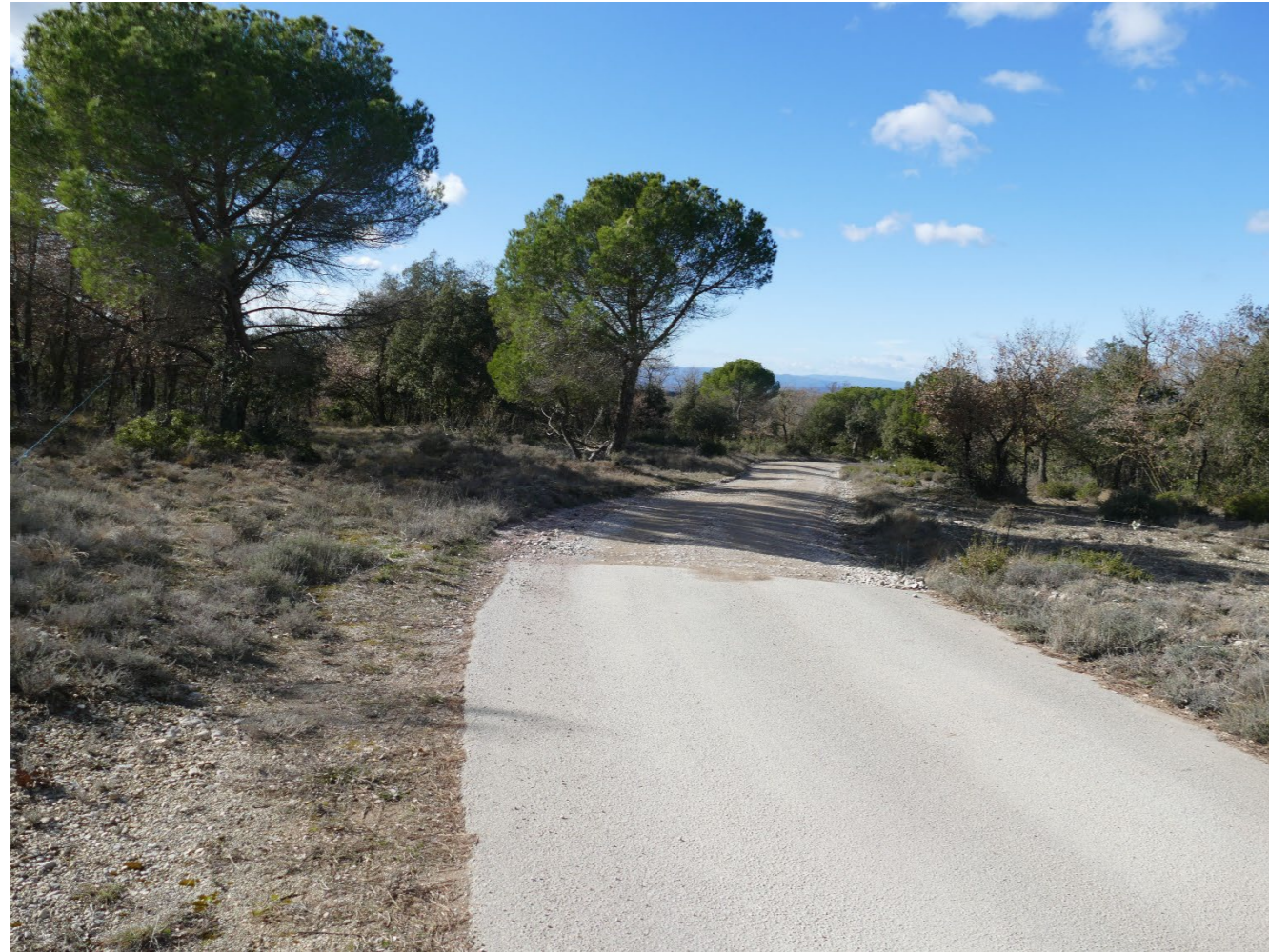
PQ 0+712, fi asfaltat i punt inici nova pavimentació
