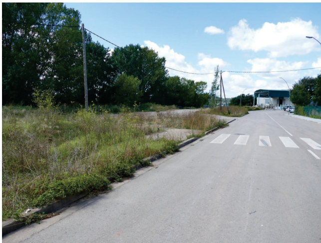
Accés vianants formigonat davant pas zebra i accés de vehicles amb grava compactada
